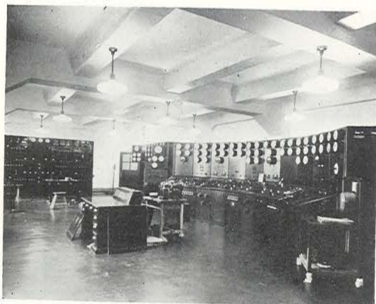
発電所配電室照明
