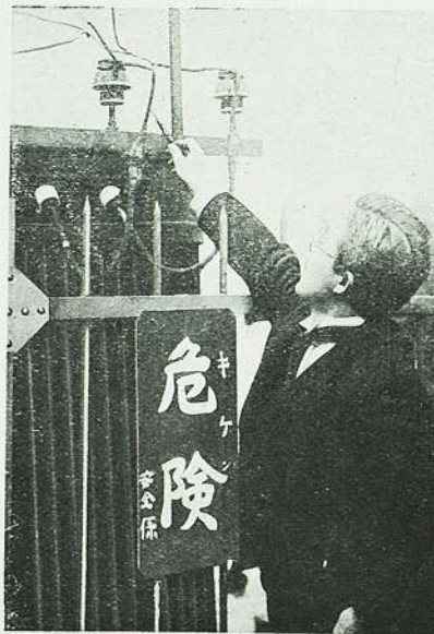
高壓 3,500 ヴォルト電線路の送電中なるや否やを完全なるゴム被覆線上よりの試験
