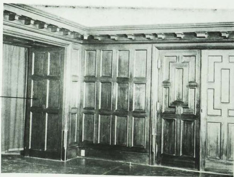
上掲分電盤取附箇所を示す
