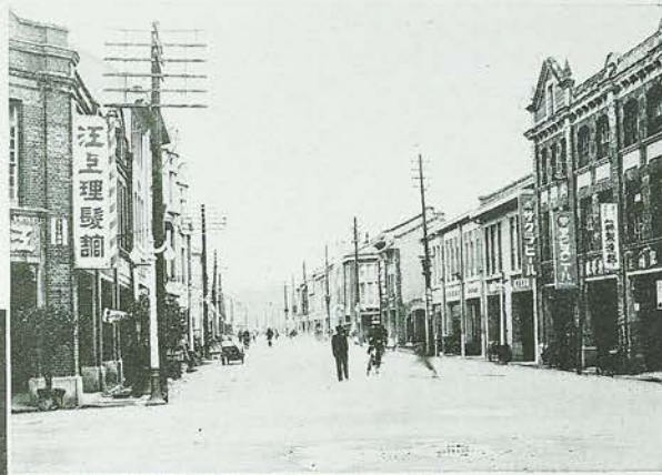
市區改正と全時に街路照明を施設したる京町通り
