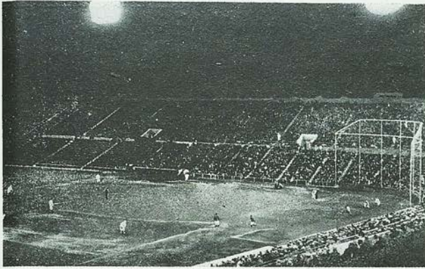
第1圖 1番新しいサンフランシスコ野球場の競技實況 (1,000ワット用投光器 308個を使用し内野 500ルクス、外野 300ルクスに照明される)
