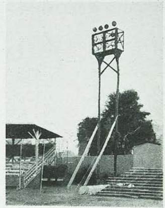
第4圖 同球場に於ける最初の木塔(地上高さ47尺)
