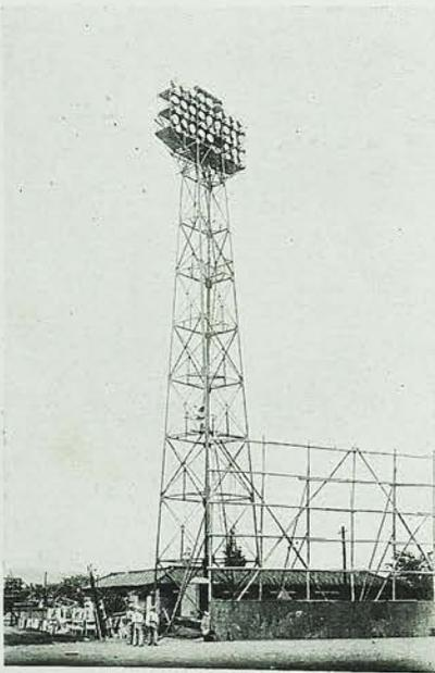
第二圖 第三號鐵塔と投光器の配置 (投光器取附工事中)
