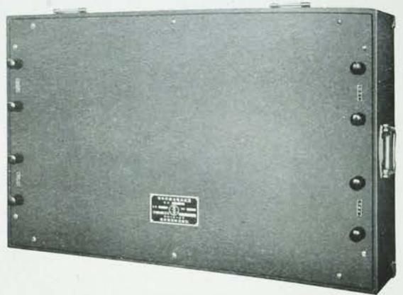
第三圖 搬送波電話装置の濾波器
