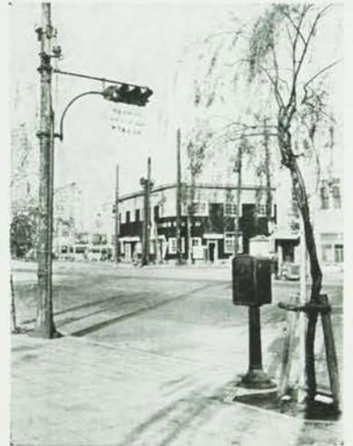
第二圖 横山町交叉點に於ける二次式信号灯と進行式プラケット式信号燈に附加せる進行式御式信号燈に注意下さい標示板に
