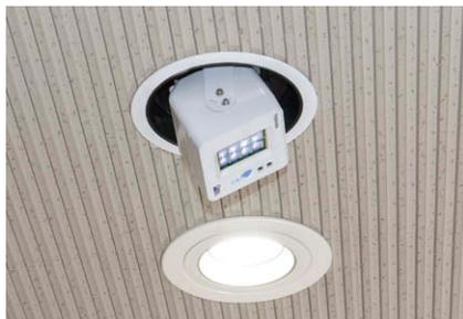
受付前天井に取り付けたウイルス抑制・除菌用UV照射器UVec①
