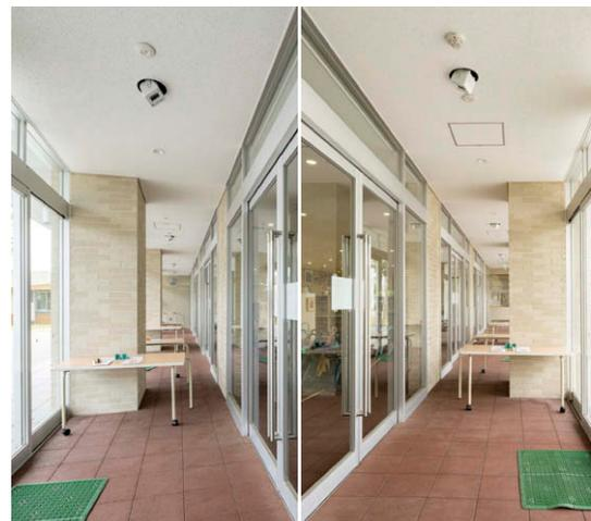
玄関風除室 ユニバーサルダウンライトタイプのUVee①を5台設置。玄関扉のドアハンドルに向けてUV照射。
