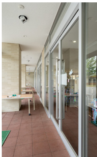
② 玄関 風除室 (5 台)
