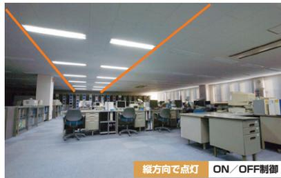
横方向の点灯から縦方向への点灯区分へ
