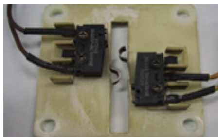
スイッチを固定している樹脂が変色、変形した状態
