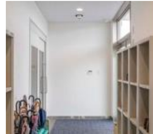
■通用口：通用口にも設置し UV照射
