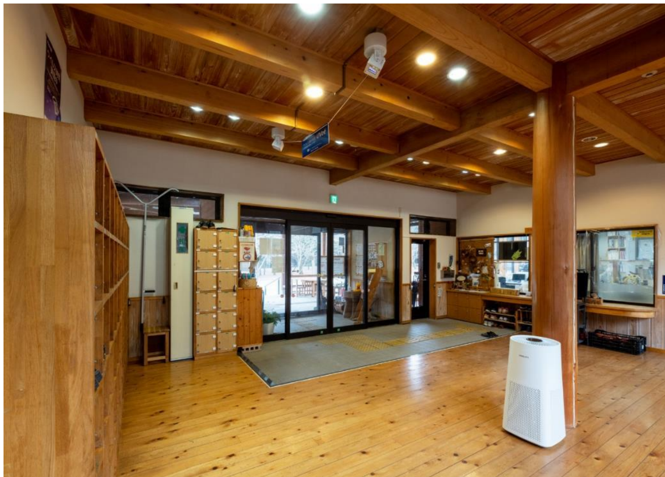
エントランスホール：2台のUVVで下駄箱を照射 UV-C空気除菌器も使用
