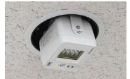
■ 2階エレベーターホール: エレベーター前は1階2階ともUVeeを設置し、人が触れる昇降ボタンを含めた空間に向けてUV照射
