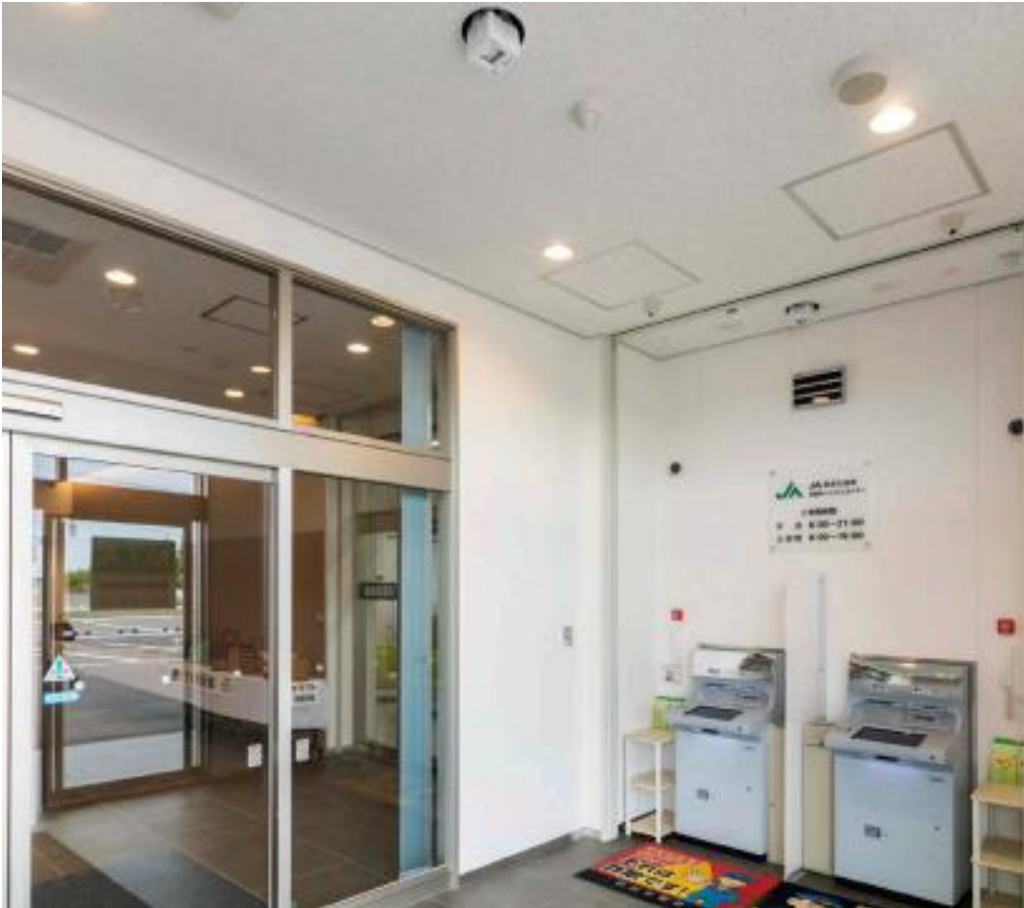
■ ATM コーナー: 1 階出入り口の風除室に設置された ATM コーナーでは風除室全体とATM のタッチパネルに向けて UVeeを設置
