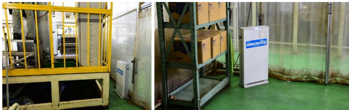
冷蔵庫解体ライン：工程に残留する冷蔵庫内残り臭の脱臭に活躍
