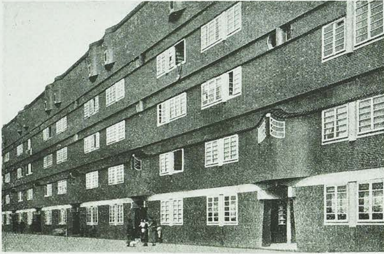
第一圖 アムステルダムの郵便局 クラーク氏設計 最上階の窓の小さきこと、荷揚用の腕の突出、水平に通る蛇腹、
