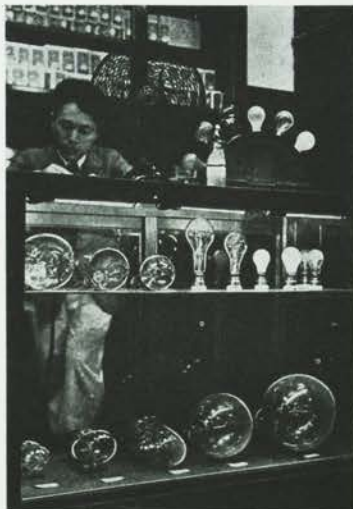
第二圖 管型電球を取付けた ショー・ケースの例 特に電球の存在を明かにする爲 下方より撮影、實際は電球は取 付枠内に隠れて全然見えぬ
