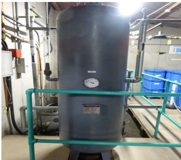
新規設置されたエアータンク
