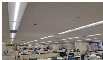
リニューアル後のLED照明の様子
