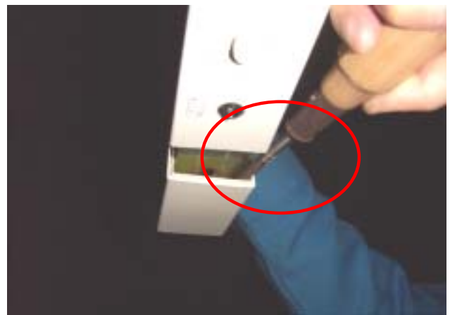
② ドライバは図のように、斜め方向から差し込んでください。
