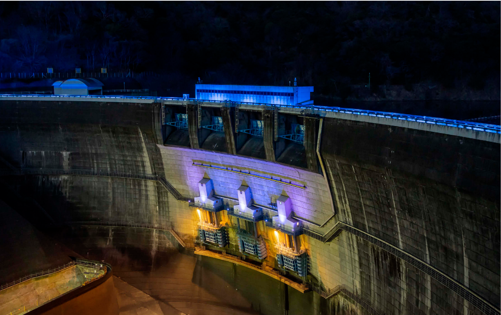
管理棟屋上から見た七タをイメージしたライトアップ演出 3台1組のフルカラーLED照明器具ColorBlast IntelliHue Powercore gen5①が3つのゲートを照射
