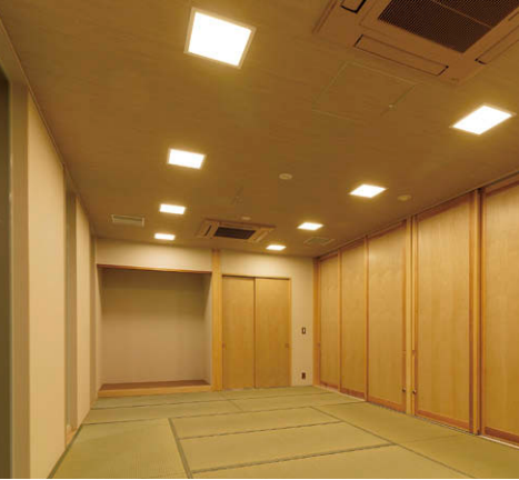
和室 LEDベースライトスクエアパネルタイプ⑧による照明
