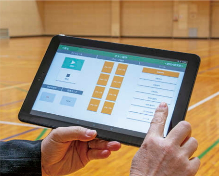
タブレット端末による照明パターン変更操作
