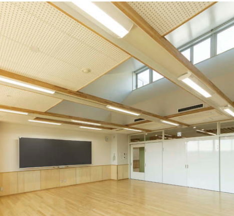
3階教室 ハイサイドライトを採用し調光タイプのスクールソフト②にあかりセンサーも設置
