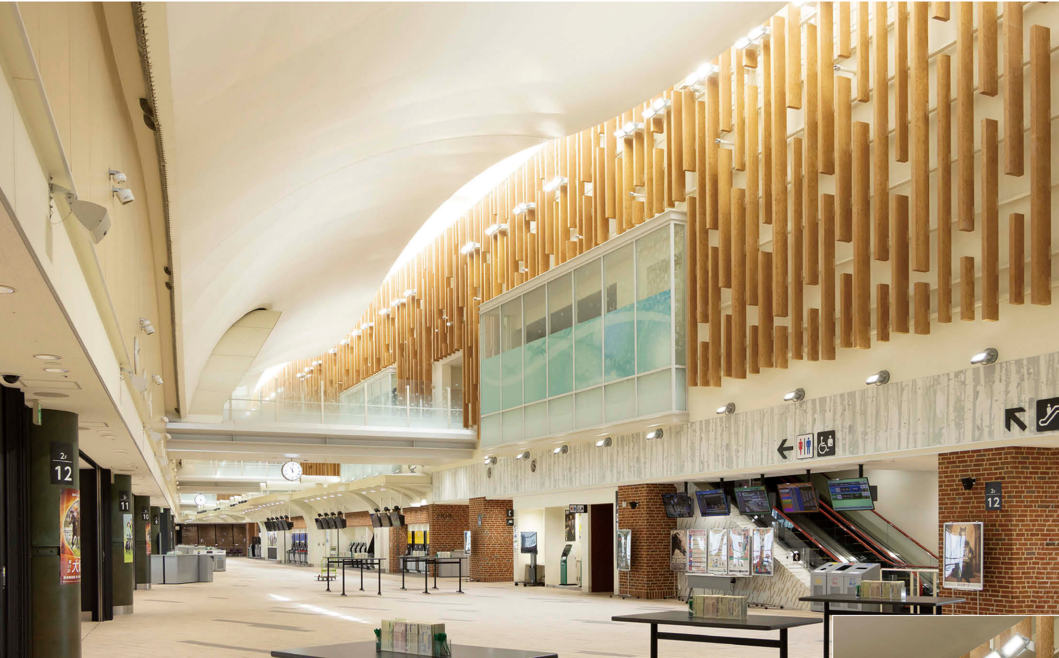
雲の広場 右手壁面中段に上向きに配置したLED投光器①が幕天井を照射し、壁面上部に下向きに配置したLED投光器②③が床面を照射
