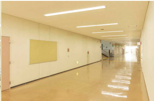
廊下 通路幅の広い廊下の照明にはLEDベースライト TENQOOシリーズ(連結用)②③④を採用
