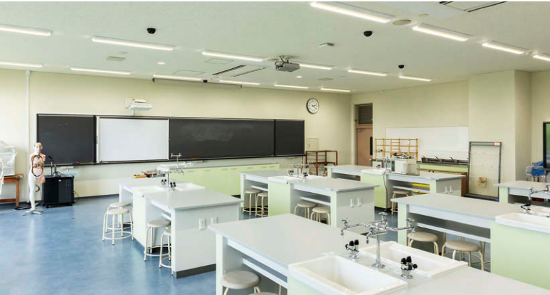
化学・生物実験室 LEDベースライト TENQOOシリーズ①とLEDユニット交換形ダウンライト⑤による照明
