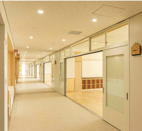
廊下 LEDユニット交換形ダウンライト④による照明
