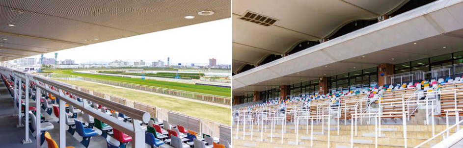
屋外スタンド LEDユニット交換形ダウンライト⑤防湿・防雨形を採用
