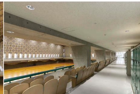
中2階の照明 観客席とロッカーのある中2階通路にLED一体形ダウンライト③を採用
