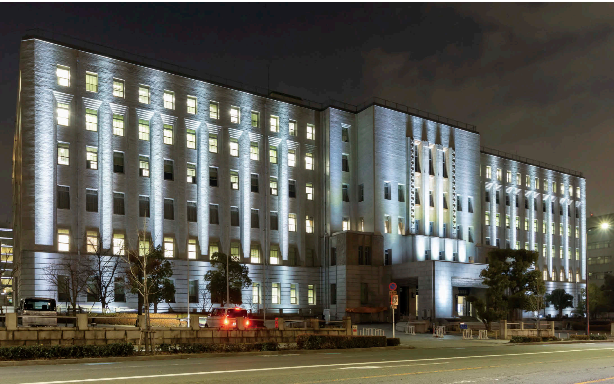
ライトアップ常時点灯(白色) フルカラーLED照明器具①が下方から上方へ大きな「面」を照射しスポットライトタイプの②が細部を照射
