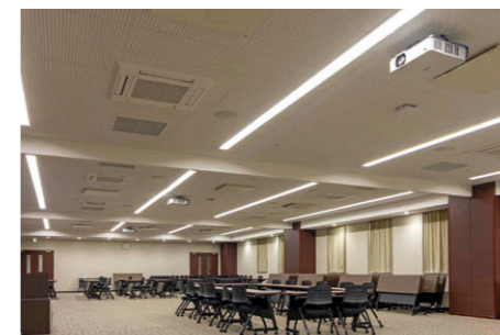
7階中央ホールの照明 連結タイプのLEDベースライト⑥⑦⑧を4列でライン配置
