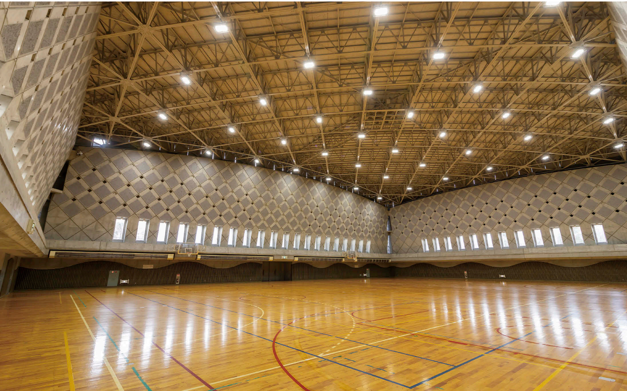
アリーナの照明 広さ47m×31m、天井高13.6mのアリーナにLED高天井器具①を47台設置し、採光窓にはLEDユニット交換形ダウンライト②を採用
