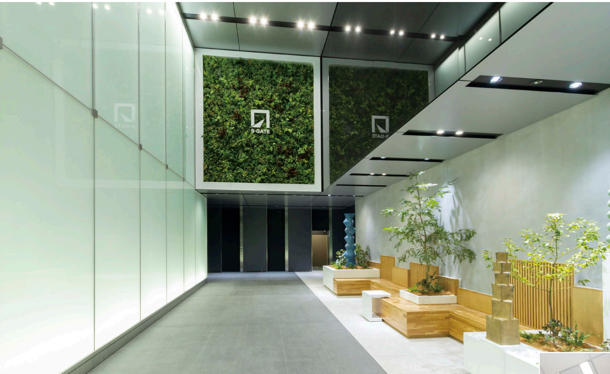
1階エントランスホールの照明 左側の光壁は中央部まで明るさが届くように集光タイプのLEDベースライト①を採用して上下に6台ずつ配置 吹き抜け天井に1,910lmのLEDダウンライト②を2灯1組計18台配置 右側スリット部には1,160lmのLEDダウンライト③を採用
