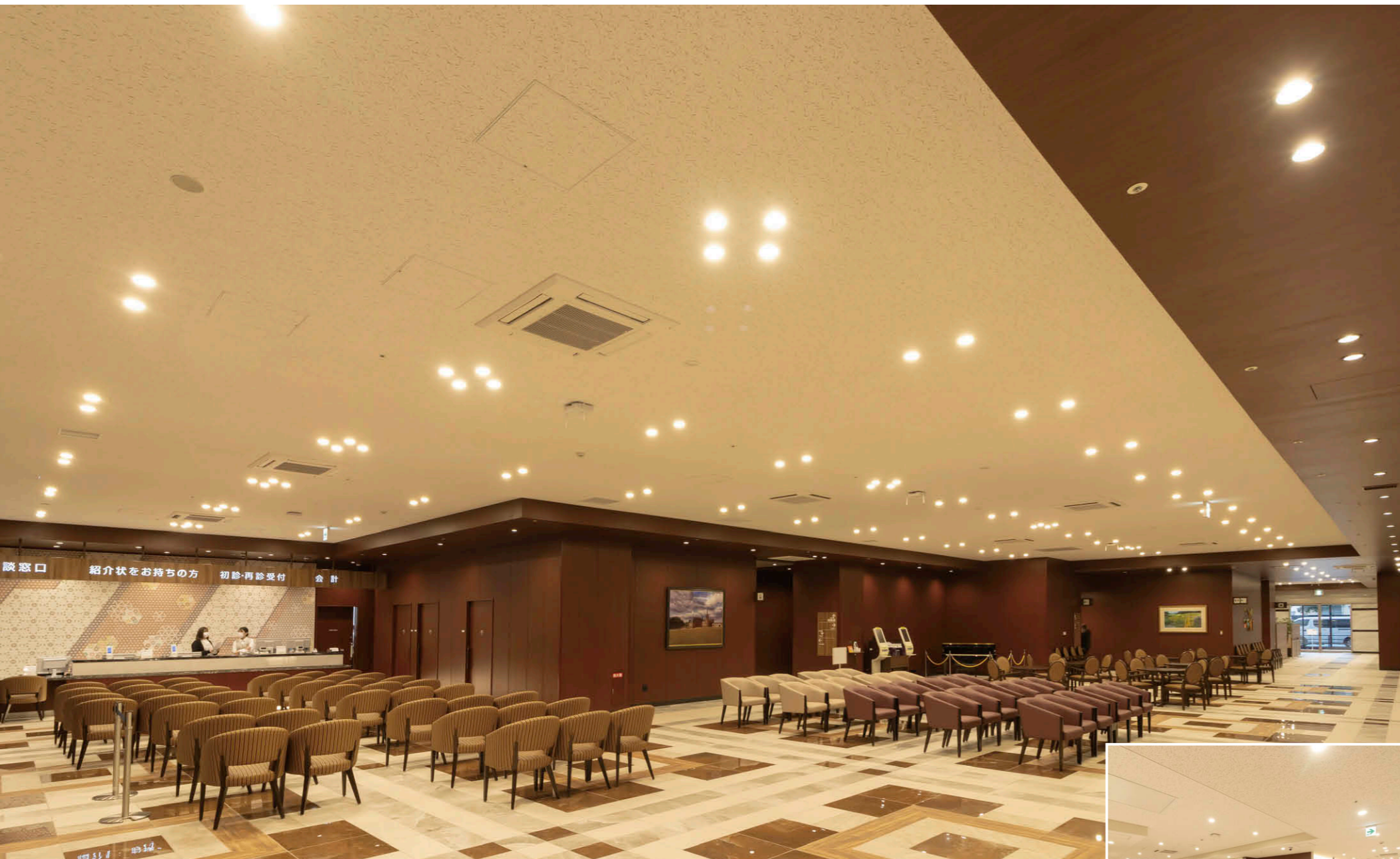
1階エントランスホールの照明 天井折上げ部には4灯または2灯を1組とした白色反射板のLEDダウンライト①を計105台配置 周縁部の下げ天井には黒色反射板のLEDダウンライト②を22台配置
