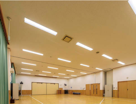
浜田学区コミュニティ防災センター(集会室) 既設器具に合わせてLEDベースライト⑥に更新
