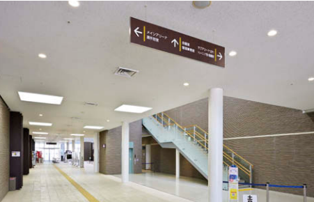
1階エントランスロビー 高効率タイプのLEDダウンライト⑥と埋込形□1257のLEDスクエア器具④を採用
