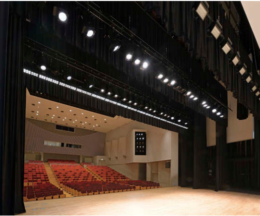
舞台照明 LEDスポットライト⑤⑨とフルカラーLEDボーダーライト⑥による照明
