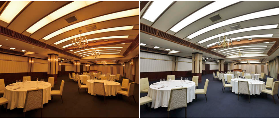
宴会場「潮騒」の照明シーン例 建築化照明には直付形の調光調色器具①144台を使用してさまざまな照明環境を創出(左/電球色パターン 右/昼白色パターン)
