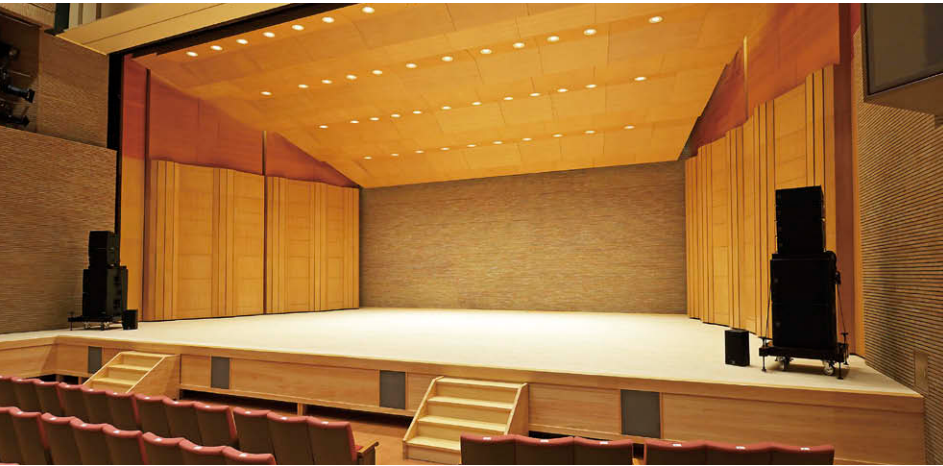
ホール舞台の照明（音響反射板） LEDシアターシリーズダウンライト⑨を12台×4列で配置
