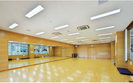
1階軽運動室 明るい21台のLEDベースライト⑥により視認性の高い空間を創出
