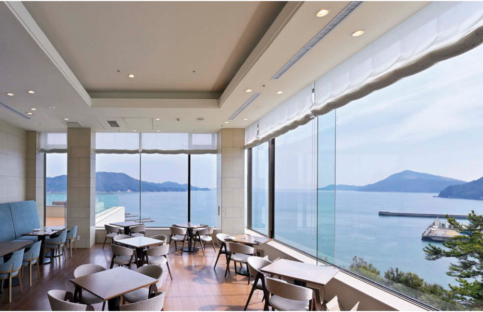
オーシャンウイング/ザ・ロビーラウンジの照明 2700KのLEDランプと組み合わせたLEDダウンライト④を計24台配置
