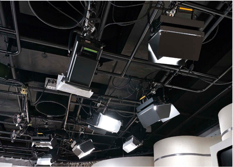
セット上部の照明配置 LEDフラッドライト①、LEDスポットライト②
