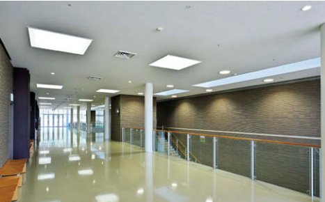
2階ロビー LEDスクエア器具④とLEDダウンライト③⑥にリニューアル
