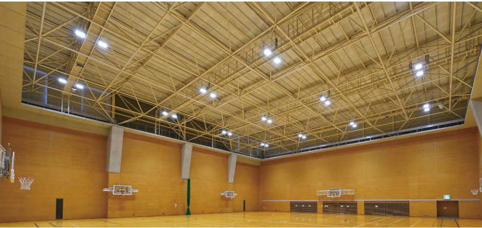
2階サブアリーナ 1kWメタルハイドランプ器具相当のLED投光器①を32台更新
