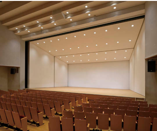
音響反射板 LEDシアターシリーズダウンライト③を採用
