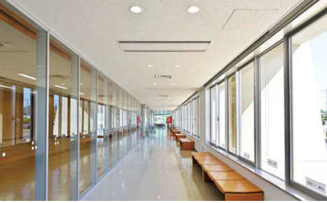
1階廊下 外光に配慮してLEDダウンライト非調光タイプ⑥と調光タイプ⑦を交互に配置
