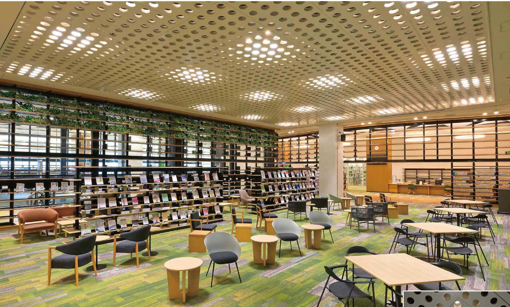
10階雑誌・新聞コーナー／イベントコーナー 優しい光が届くLEDユニット交換形ダウンライト②とLED一体形ダウンライト③による照明
