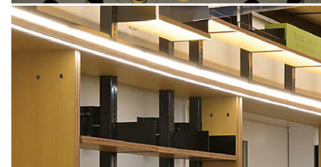
(上) LEDユニット交換形ダウンライトとLED一体形ダウンライト (下) 連結配置したLEDライン器具によるコブ照明
