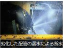
劣化した配管の漏水による断水
