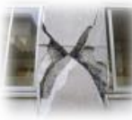
耐震化未完了の建物が大規模地震により大きな被害を受けた例
